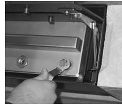
11. Закройте крышку корпуса обшивки камина, при этом обращайте внимание на то, чтобы крышка не попала в зону огня, соблюдайте равномерное расстояние до желоба горелки. Затем вставьте защитные стеклянные панели.
